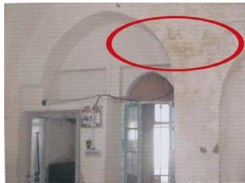
شكل رقم (6.53) مشاكل الرطوبة
